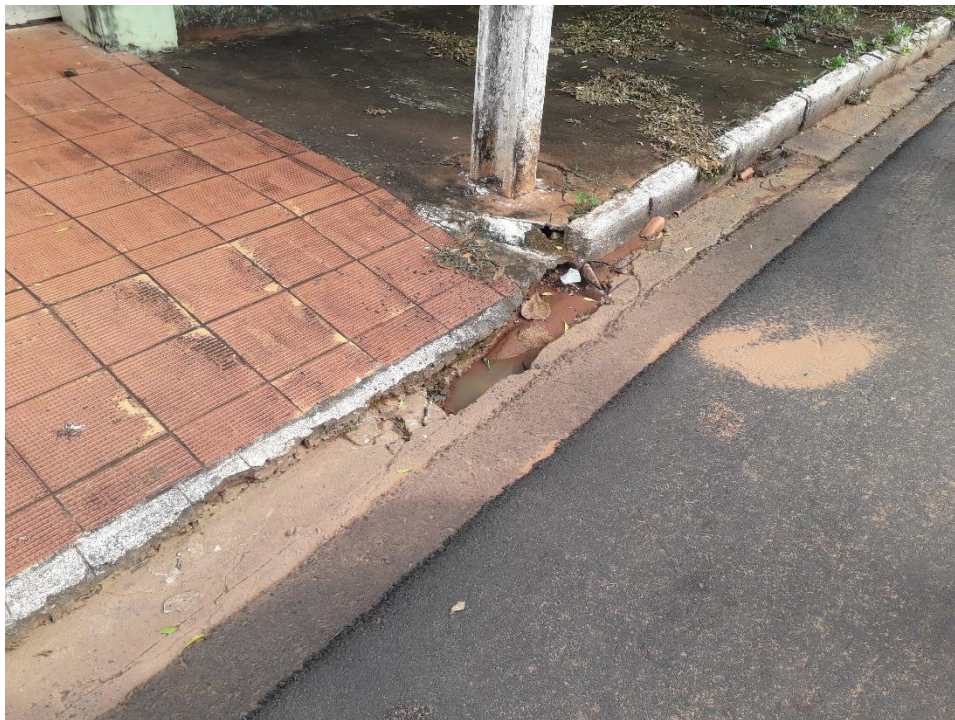
Figura 60 - pavimentação, sarjeta e meio fio como sistema recém-construídos em principal avenida de Cachoeirinha
