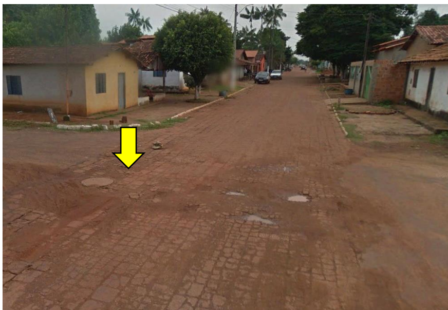
Figura 40 - Poço de visita executado na área urbana de Cachoeirinha (6° 7'3.29"S e 47°55'11.27"O)
