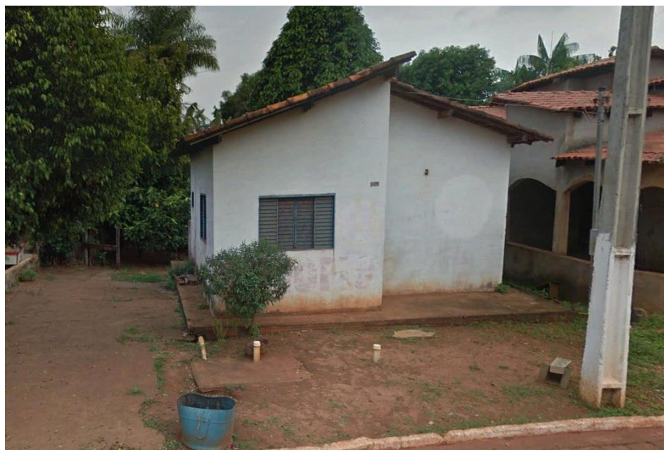
Figura 48 - Vista da fossa rudimentar instalada no setor urbano de Cachoeirinha (6°7'4.07"S e 47°55'11.55"O)
