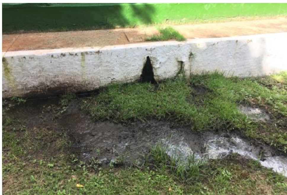
Figura 51 - Esgoto escoando a céu aberto em Cachoeirinha (6°6'53.97"S e 47°55'3.35"O)
