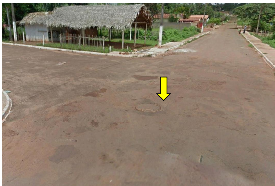
Figura 39 - Poço de visita executado na área urbana de Cachoeirinha (6° 7'4.84"S e 47°55'9.59"O)
