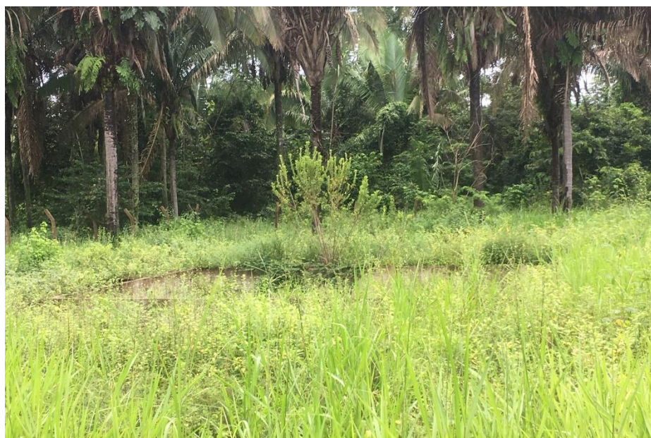
Figura 46 - Vista do leito de secagem da ETE de Cachoeirinha
