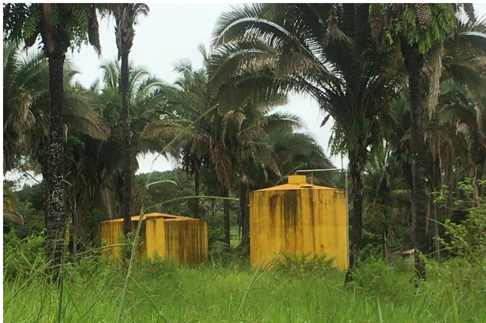
Figura 45 - Vista da entrada da ETE de Cachoeirinha
