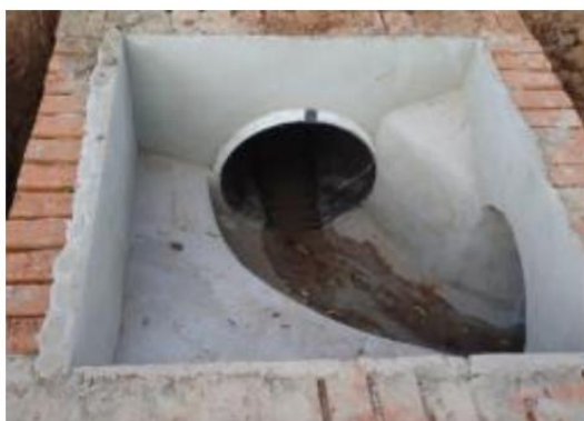
Figura 01: Fundo das caixas de inspeção.
