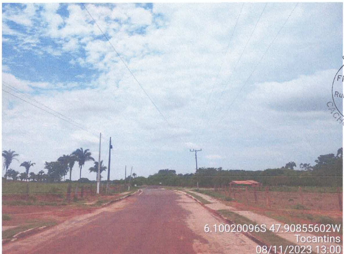
Foto 03: Local onde executado o Portal de Entrada da Cidade.
