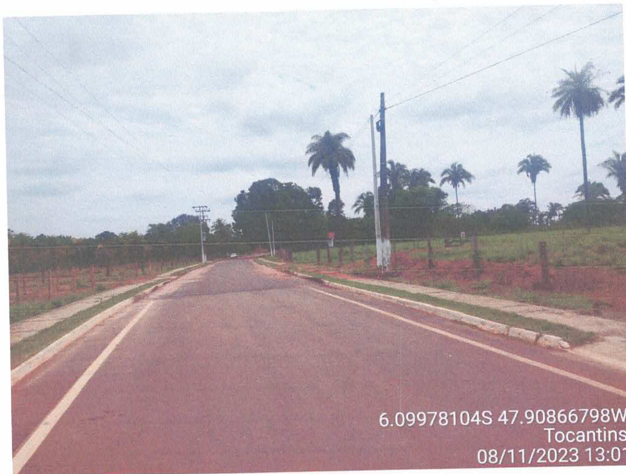
Foto 01: Local onde executado o Portal de Entrada da Cidade.
