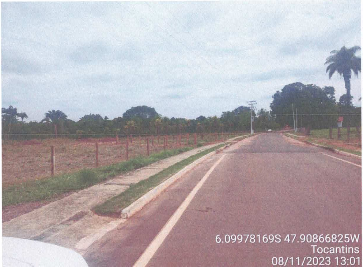
Foto 02: Local onde executado o Portal de Entrada da Cidade.
