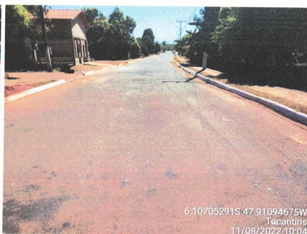
Foto 20: Vista geral do pavimento da Av. Palmeiras.
