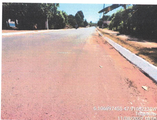
Foto 21: Vista geral do pavimento da Av. Palmeiras.
