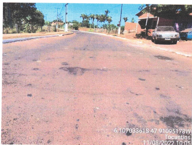
Foto 19: Vista geral do pavimento da Av. Palmeiras.
