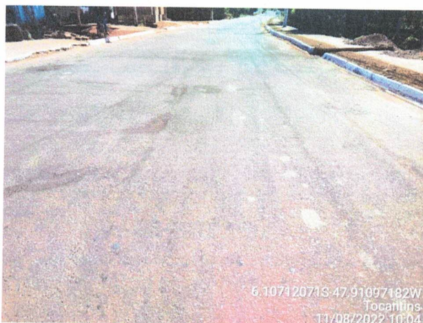
Foto 17: Vista geral do pavimento da Av. Palmeiras.
