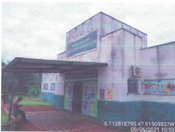
Foto 05: Vista Frontal do Prédio.
