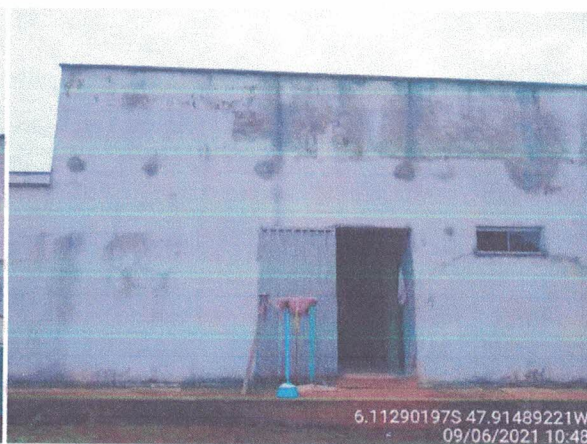
Foto 06: Vista Fundo do Prédio.
