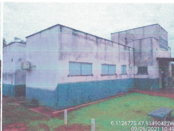
Foto 02: Vista Frontal do Prédio.
