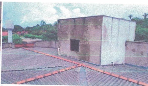
Foto 24: Cobertura existente em telha fibrocimento.
