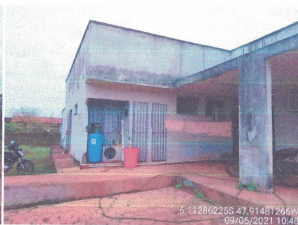
Foto 04: Vista Fundo do Prédio.
