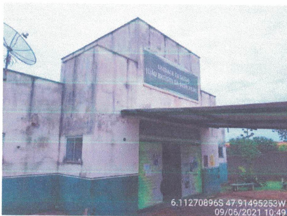
Foto 01: Vista Frontal do Prédio.
