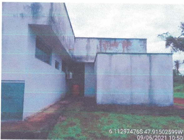
Foto 07: Vista Fundo do Prédio.
