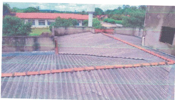
Foto 23: Cobertura existente em telha fibrocimento.
