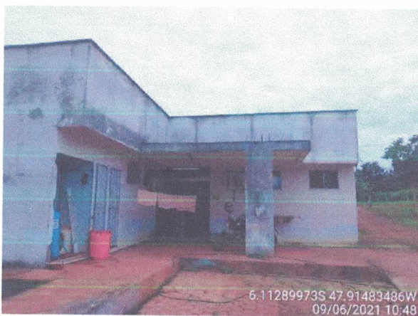
Foto 03: Vista Fundo do Prédio.
