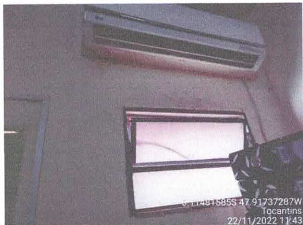
Foto 57: Sala do gabinete a ser reformulada. Paredes a serem demolidas. Paredes com infiltração. Fiação exposta, esquadrias danificadas.
