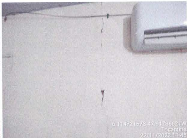
Foto 70: Sala da contabilidade a ser reformulada. Paredes com rachaduras. Paredes com infiltração. Fiação exposta, esquadrias danificadas.
