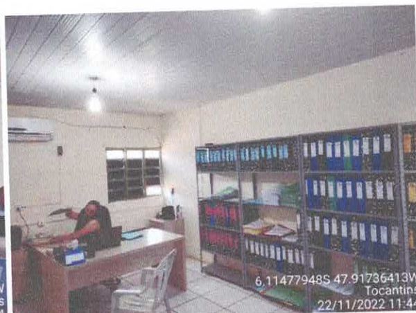
Foto 64: Sala da contabilidade a ser reformulada. Paredes a serem demolidas. Paredes com infiltração. Fiação exposta, esquadrias danificadas.
