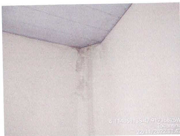
Foto 53: Sala do gabinete a ser reformulada. Paredes a serem demolidas. Paredes com infiltração.
