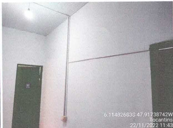
Foto 58: Sala do gabinete a ser reformulada. Paredes a serem demolidas. Paredes com infiltração. Fiação exposta, esquadrias danificadas.
