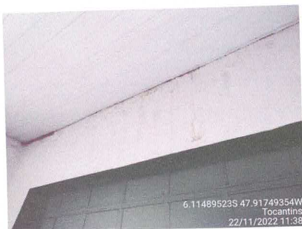
Foto 33: Vazamento geral do telhado. Telhas quebradas e calhas danificadas.
