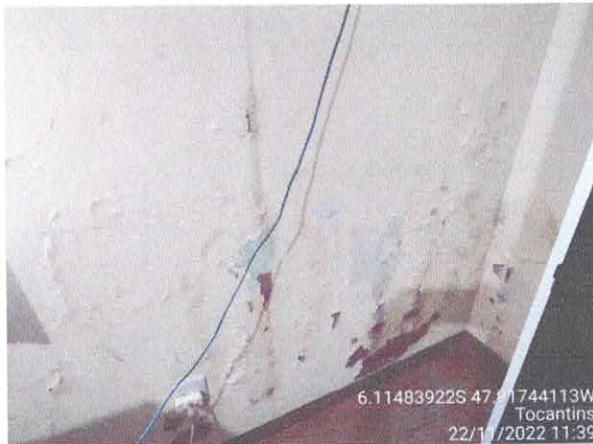
Foto 43: Sec. Educação: Vazamento do telhado. infiltração e paredes danificadas com revestimento solto, fiação exposta
