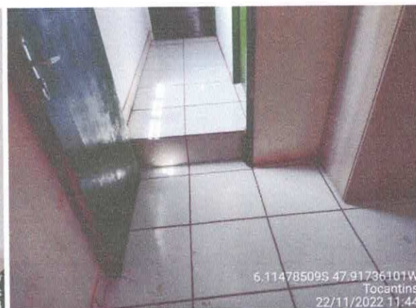
Foto 62: Sala da contabilidade a ser reformulada. Paredes a serem demolidas. Paredes com infiltração. Degrau no piso a ser retirado com a demolição do contra-piso e rebaixo do nível.
