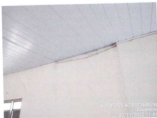
Foto 65: Sala da contabilidade a ser reformulada. Paredes a serem demolidas. Paredes com infiltração. Fiação exposta, esquadrias danificadas.
