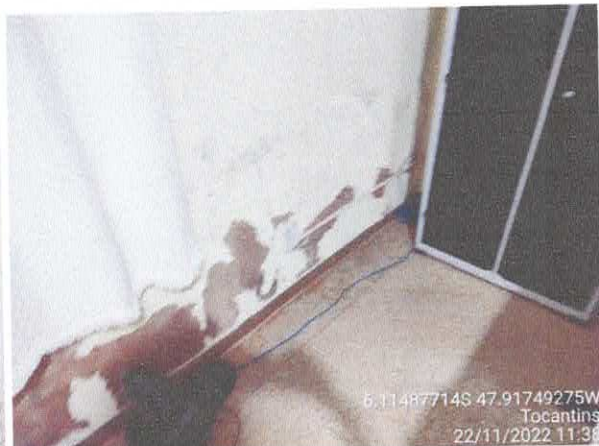
Foto 38: Sala da licitação: Vazamento do telhado. infiltração e paredes danificadas com revestimento solto.
