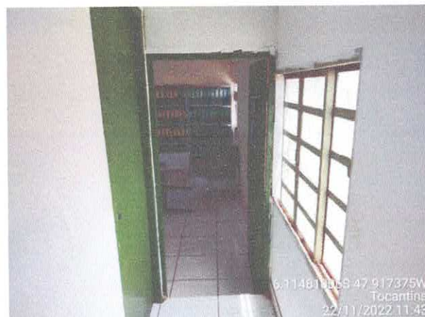
Foto 59: Sala da contabilidade a ser reformulada. Paredes a serem demolidas. Paredes com infiltração. Fiação exposta, esquadrias danificadas.
