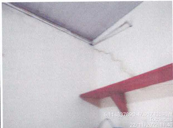
Foto 44: Sec. Educação: Vazamento do telhado. infiltração e paredes danificadas com revestimento solto, fiação exposta.
