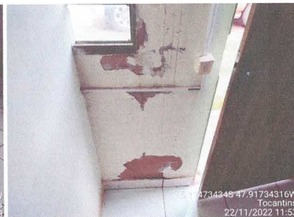
Foto 74: Sala da coletoria: paredes com rachaduras. Paredes com infiltração. Fiação exposta, esquadrias danificadas.
