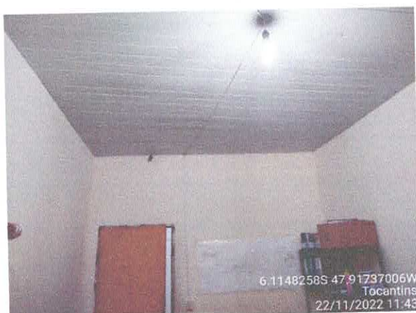
Foto 55: Sala do gabinete a ser reformulada. Paredes a serem demolidas. Paredes com infiltração. Portas danificadas.
