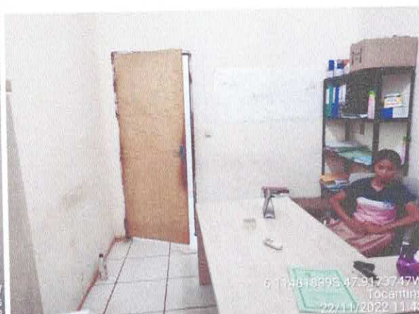
Foto 56: Sala do gabinete a ser reformulada. Paredes a serem demolidas. Paredes com infiltração. Portas danificadas.
