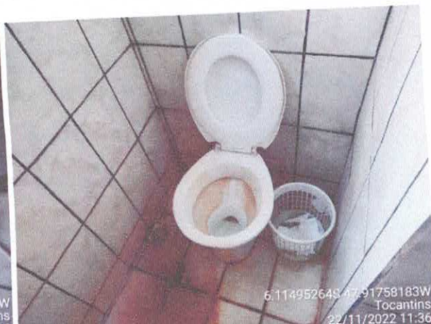
Foto 26: Banheiro Feminino a ser reformulado.
