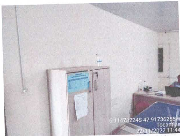
Foto 63: Sala da contabilidade a ser reformulada. Paredes a serem demolidas. Paredes com infiltração. Fiação exposta, esquadrias danificadas.
