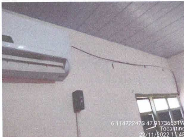
Foto 69: Sala da contabilidade a ser reformulada. Paredes com rachaduras. Paredes com infiltração. Fiação exposta, esquadrias danificadas.
