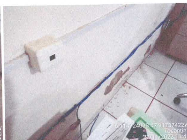
Foto 68: Sala da contabilidade a ser reformulada. Paredes a serem demolidas. Paredes com infiltração. Fiação exposta, esquadrias danificadas.
