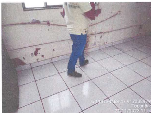
Foto 73: Sala da coletoria: paredes com rachaduras. Paredes com infiltração. Fiação exposta, esquadrias danificadas.
