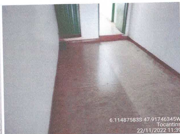
Foto 36: Será assentado piso em parcelanato sobre piso de granitina existente. Degrau em piso deverá ser executado rampa.
