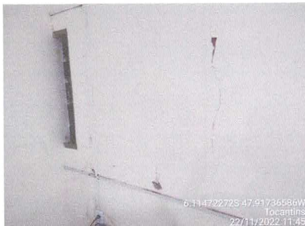
Foto 71: Sala da contabilidade a ser reformulada. Paredes com rachaduras. Paredes com infiltração. Fiação exposta, esquadrias danificadas.
