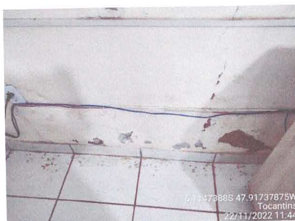
Foto 67: Sala da contabilidade a ser reformulada. Paredes a serem demolidas. Paredes com infiltração. Fiação exposta, esquadrias danificadas.
