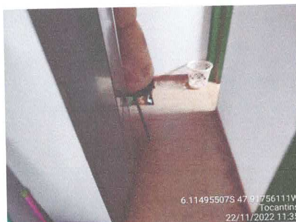
Foto 21: Hall dos banheiros.
