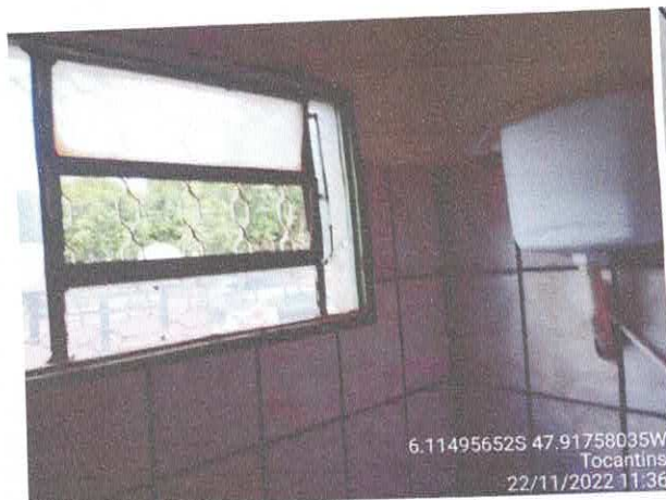
Foto 25: Banheiro Feminino a ser reformulado.
