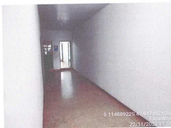
Foto 35: Será assentado piso em parcelanato sobre piso de granitina existente. Degrau em piso deverá ser executado rampa.
