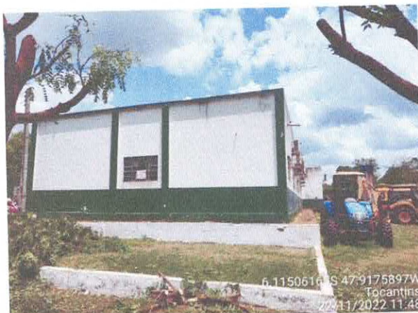
Foto 11: Fachada lateral do prédio da prefeitura.
