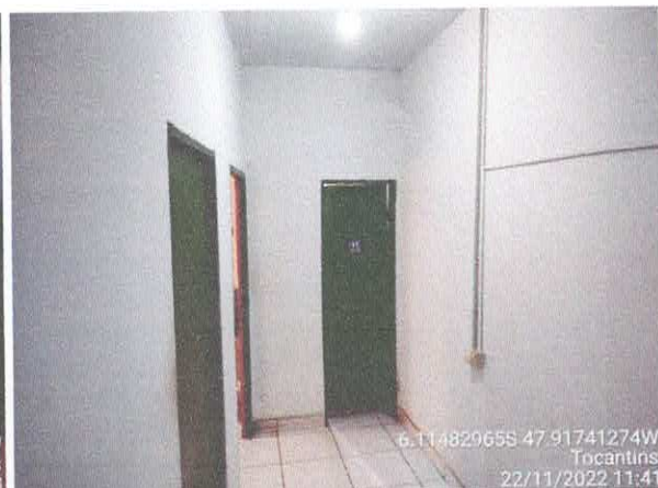
Foto 46: Paredes do gabinete a serem demolidas.
