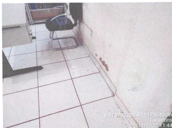
Foto 61: Sala da contabilidade a ser reformulada. Paredes a serem demolidas. Paredes com infiltração. Fiação exposta, esquadrias danificadas.
