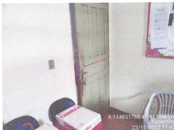
Foto 43: Sec. Educação: Vazamento do telhado. infiltração e paredes danificadas com revestimento solto, fiação exposta. Portas danificadas.
