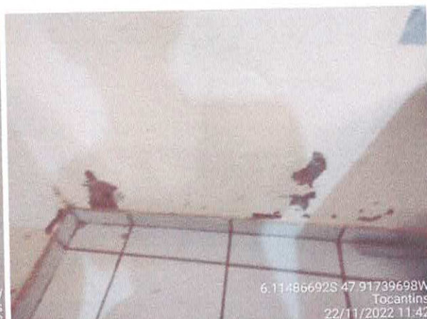
Foto 52: Sala do gabinete a ser reformulada. Paredes a serem demolidas. Paredes com infiltração.
