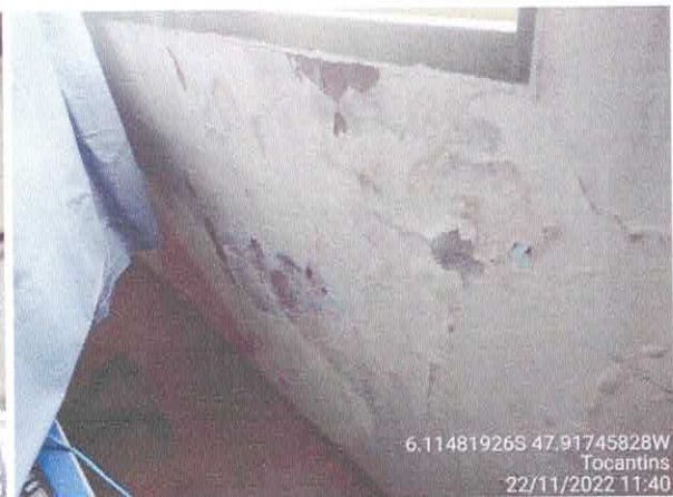
Foto 46: Sec. Educação: Vazamento do telhado. infiltração e paredes danificadas com revestimento solto, fiação exposta.
