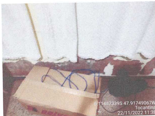
Foto 39: Sala da licitação: Vazamento do telhado. infiltração e paredes danificadas com revestimento solto.
